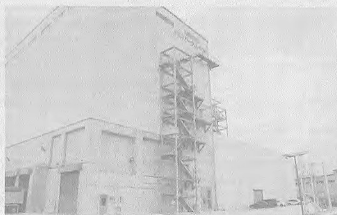
東三河バイオマス発電所
